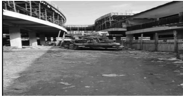
Gambar 3 Bukti Pengadaan Sarana dan Prasarana Berupa Pembangunan Gedung Kelas.
