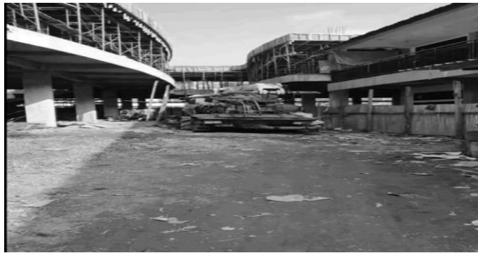
Gambar 2 Bukti Pengadaan Sarana dan Prasarana Berupa Pembangunan Gedung Kelas.
